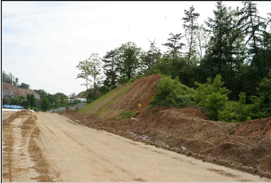
【그림 3】 깎기비탈면 시점부 측면 사진
