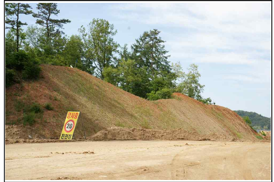
【그림 4】 깎기비탈면 종점부 측면 사진
